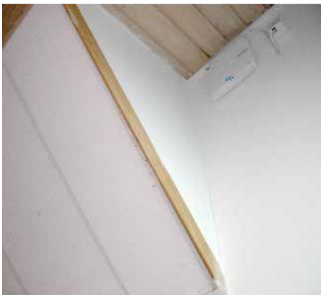
Diffusjonsløsning med spaltepanel.
